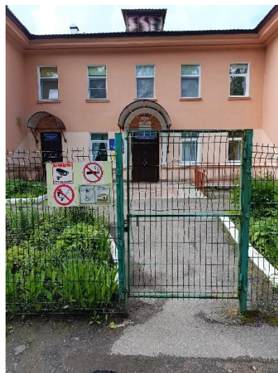
Фото №2 Вход на территорию
